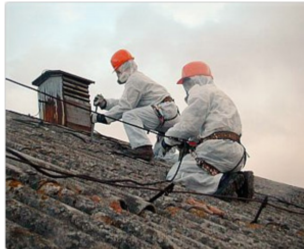
Obrázok: Materiál s obsahom azbestu používaný ako strešná krytina
