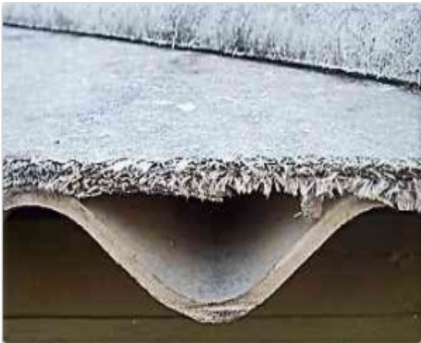
Obrázok: Materiál s obsahom azbestu používaný ako strešná krytina
