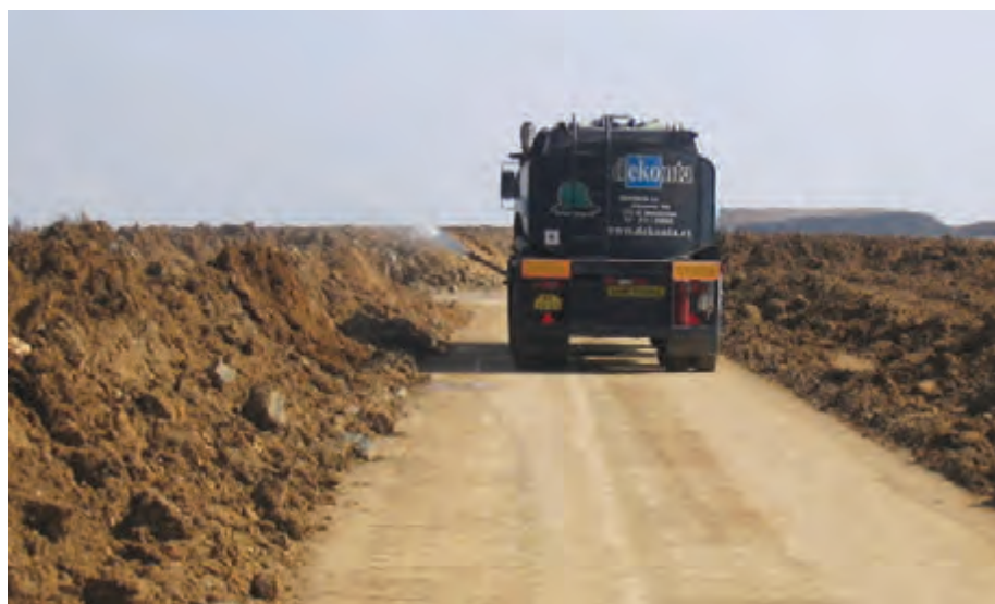
Obr. 4 Aplikácia biopreparátu na znečistené zeminy; vpravo kultivácia (prekopávanie, prevzdušňovanie)
