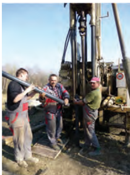
Z realizácie monitorovacích vrtov v teréne.
