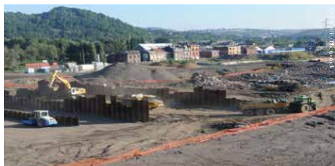
Cokerie Flemalle site
